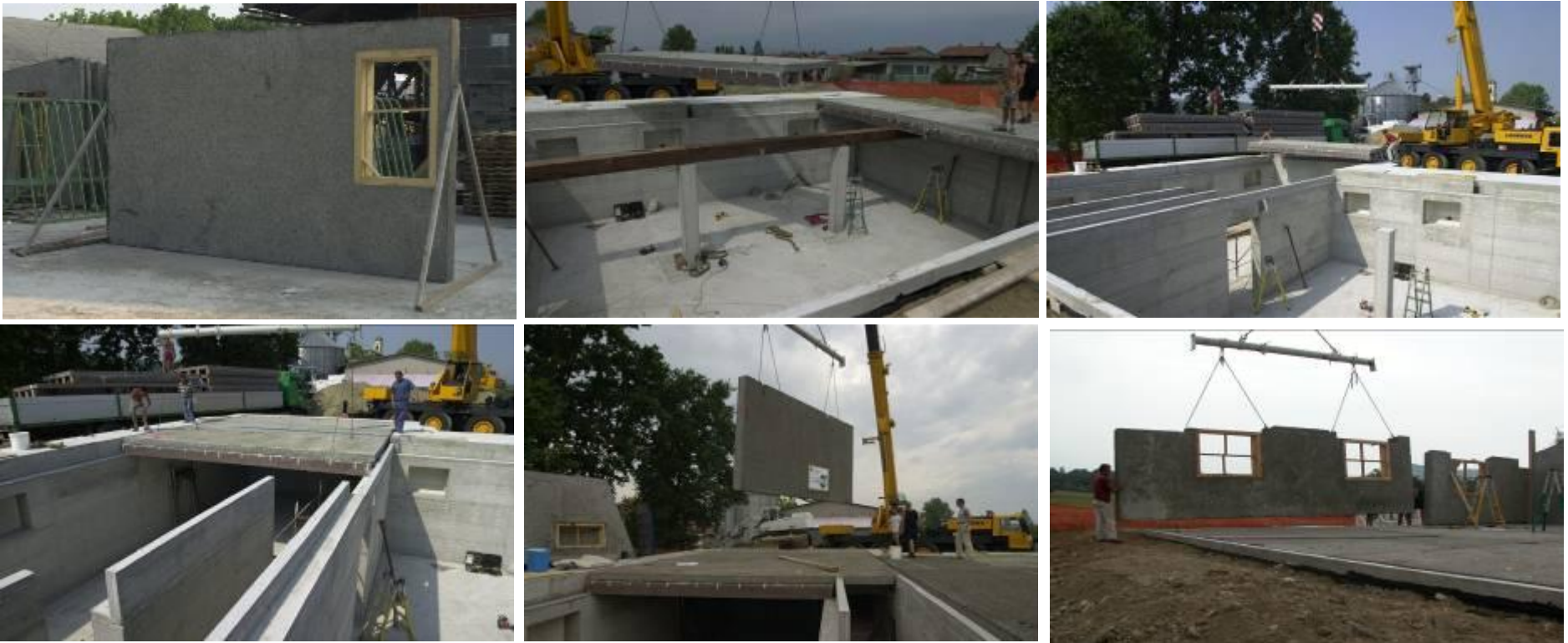
Sequenza fotografica di casa ecologica realizzata con il metodo costruttivo prima descritto. Parte 1
